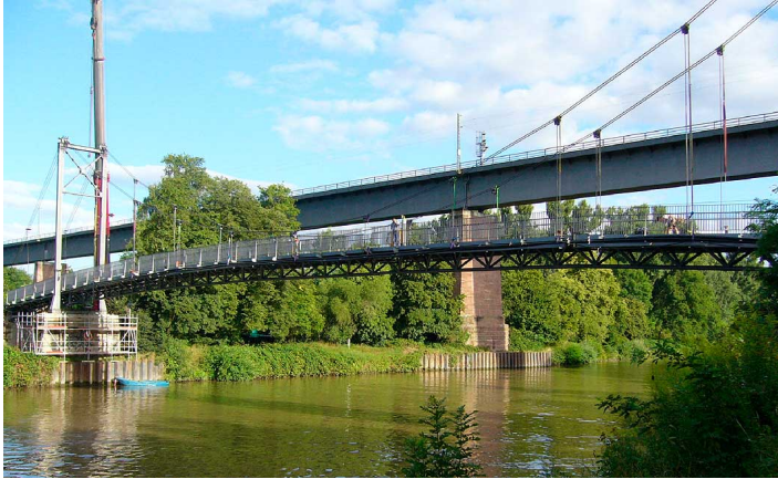
Fußgängerbrücke mit neuem Überbau
