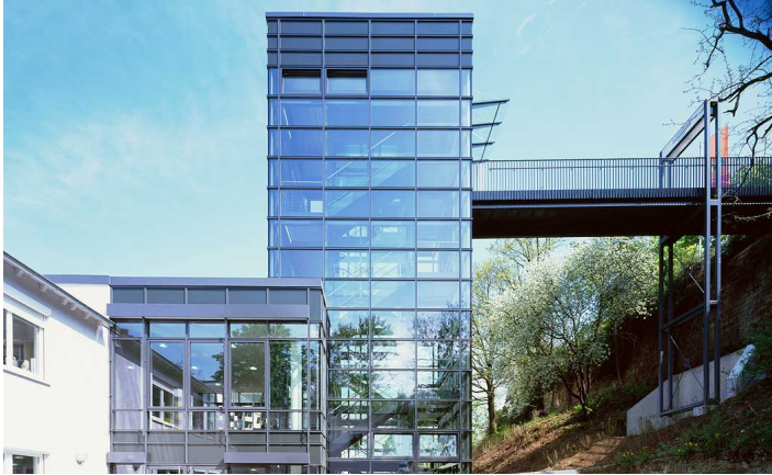
Treppenhaus- und Aufzugsturm
